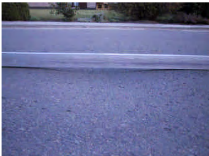
verzakkingen in het wegdek tot een diepte van 3,5 centimeter – toestand is verslechterend
