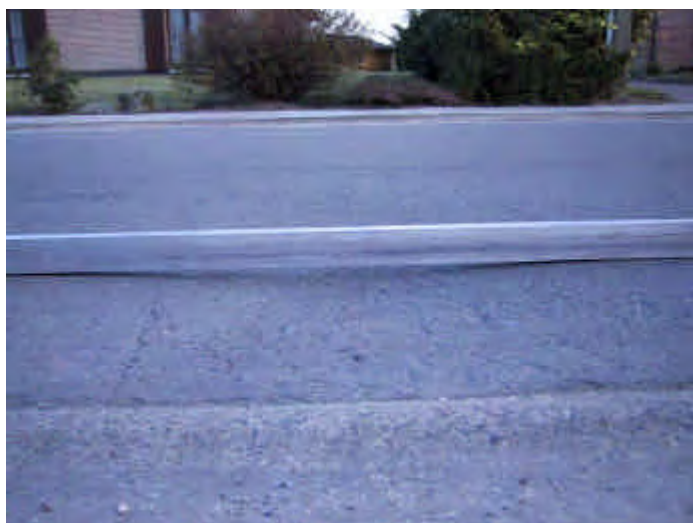
Wegdek is reeds gescheurd ter hoogte van het gas-aansluitpunt van woning Leegstraat 185.
