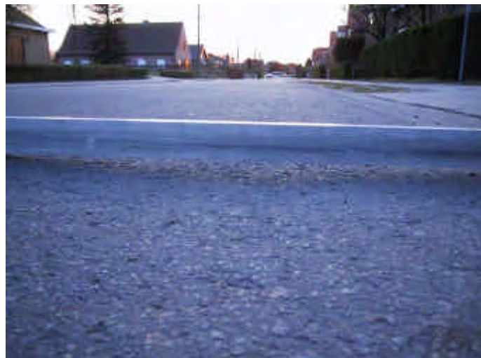
verzakkingen in het wegdek tot een diepte van 3,5 centimeter – toestand is verslechterend
