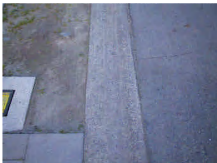
Wegdek is reeds gescheurd ter hoogte van het gas-aansluitpunt van woning Leegstraat 185.
