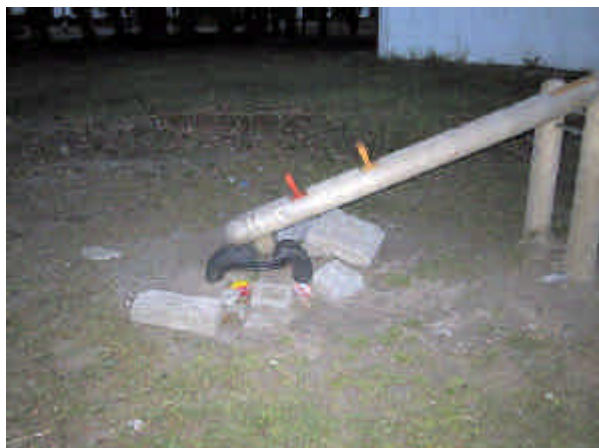
steenpuin aan schommel geeft gevaar voor kwetsen: verwijderen beschadiging loopvloer van speeltoestel met glijbaan: herstellen
